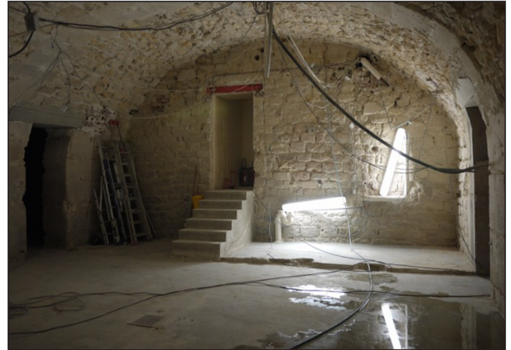
ATELIER DES CADRES – ESPACE DE PRÉSENTATION (AVANT ET PENDANT LES TRAVAUX)
